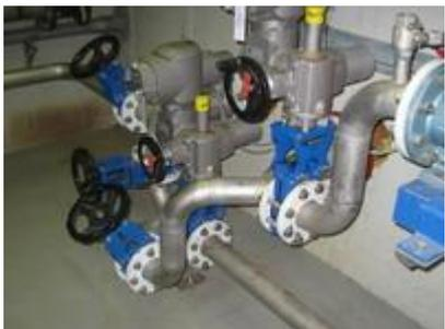
Шиберные ножевые задвижки используются в тяжелых условиях, при которых любая другая арматура оказывается неработоспособной.
